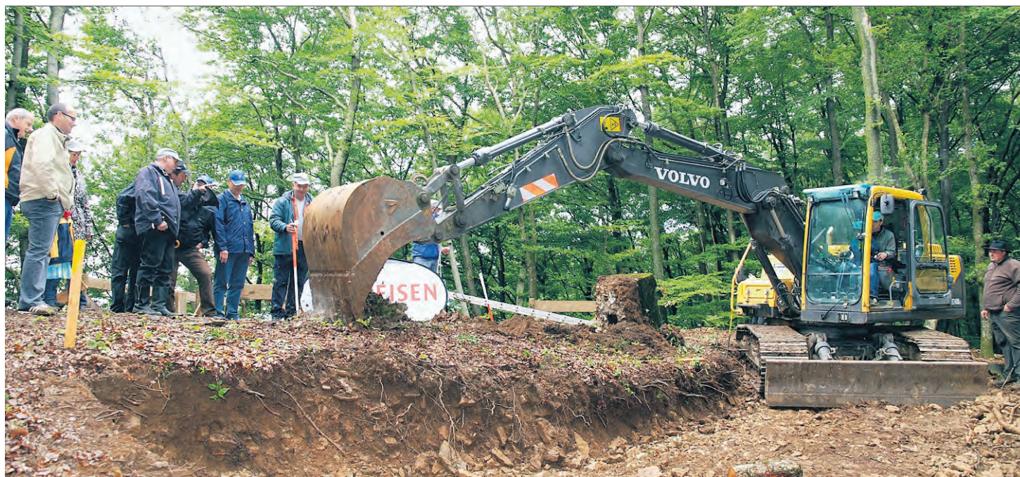
ES GEHT LOS Zuerst mit dem Bagger, dann mit der Schaufel wird der Grund für den Aussichtsturm vorbereitet. SH
